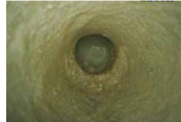
คราบตะกรันที่อยู่ภายในท่อ
